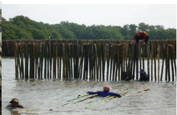
ภาพที่ 8 วิธีการปักไม้ไผ่ชะลอคลื่น ที่มา : กรมทรัพยากรทางทะเลและชายฝั่ง (2558)
