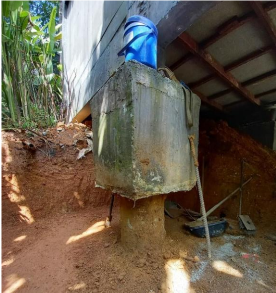
รูปที่ 6 การขุดเปิดเพื่อสำรวจลักษณะของโครงสร้างเดิม
