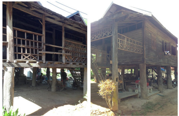
ภาพที่ 9 สถาปัตยกรรมพื้นถิ่นของชุมชนบุญเรือง เป็นรูปแบบอาคารไม้ใต้ถุนสูง เสาไม้สักเป็นลำต้นมีขนาดใหญ่
