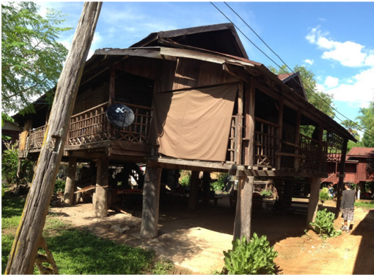
ภาพที่ 9 สถาปัตยกรรมพื้นถิ่นของชุมชนบุญเรือง เป็นรูปแบบอาคารไม้ใต้ถุนสูง เสาไม้สักเป็นลำต้นมีขนาดใหญ่
