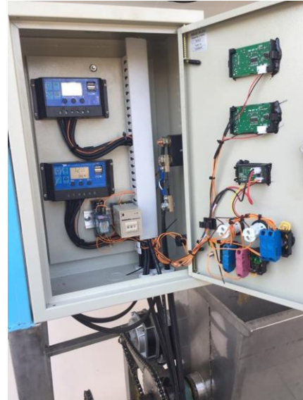
ภาพที่ 3 การติดตั้งตู้คอนโทรลระบบพลังงานแสงอาทิตย์
