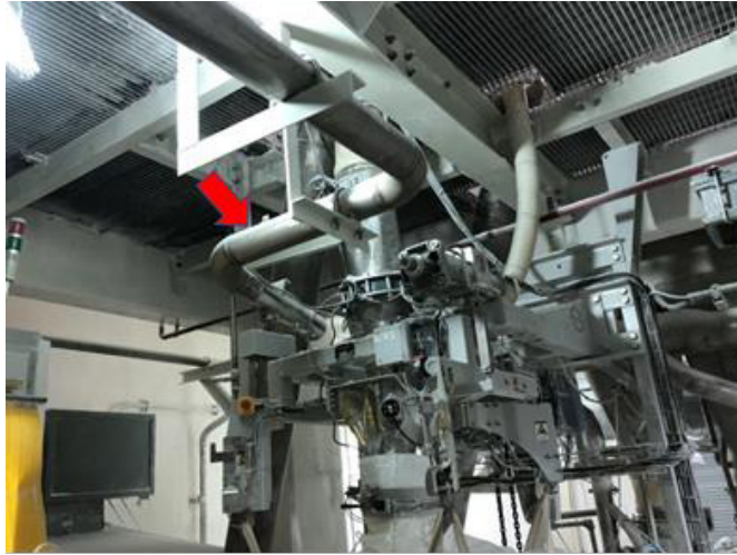
รูปภาพประกอบ 7 ติดตั้งท่อลมดูดฝุ่นละอองแป้ง
