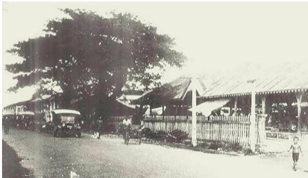
รูปที่ 1 ตลาดบันล้า (ตลาดสดสาธารณะ 1 ในอดีต)
