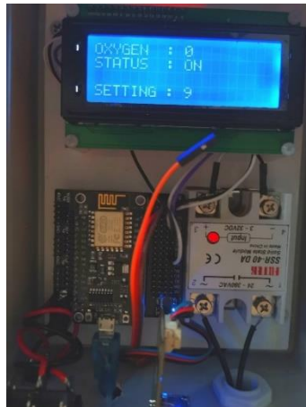
ภาพที่ 6 ภาพการติดตั้งอุปกรณ์
