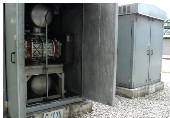
ภาพที่ 1 ลักษณะของเครื่องคอมเพรสเซอร์ส่งเม็ดพลาสติก
