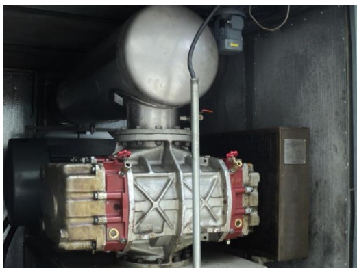
ภาพที่ 1 ลักษณะของเครื่องคอมเพรสเซอร์ส่งเม็ดพลาสติก
