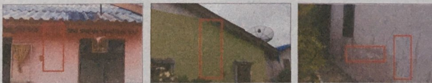
ภาพที่ 3 บ้านที่ได้รับผลกระทบจากการสั่นสะเทือนของเครื่องบินขณะบินขึ้นลง ซึ่งทำให้บ้านเกิดรอยแตกร้าว
