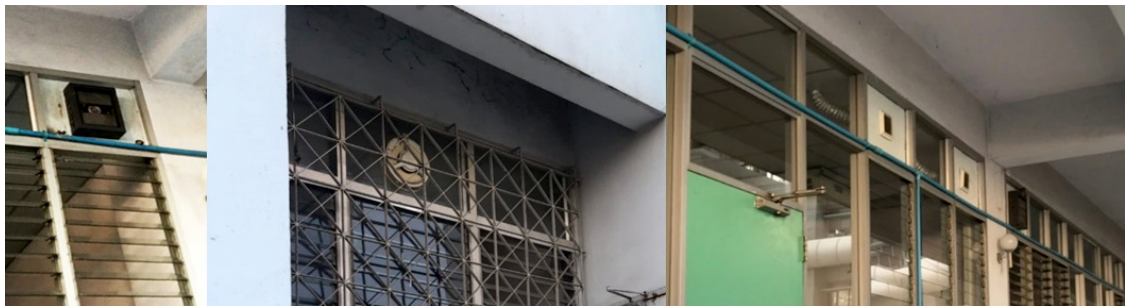
ภาพที่ 3 การติดตั้งอุปกรณ์ระบายอากาศด้วยวิธีกลภายในอาคารหอผู้ป่วยรวมโรงพยาบาลปทุมธานี
