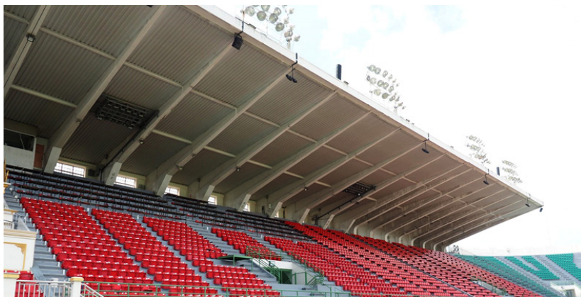
ภาพที่ 11 ภาพถ่ายอัฒจันทร์ฝั่งทิศตะวันตกแสดงโครงสร้างรับหลังคาชุดเก่า (สร้างเมื่อ พ.ศ. 2481-2484) ที่ได้รับการปรับปรุง แล้วเมื่อ พ.ศ. 2513 และชุดใหม่ที่ได้รับการต่อเติมเมื่อปี พ.ศ. 2507-2509 ที่มา: ปิ่นทาร์ย์ วิจารณ์ (2562)
