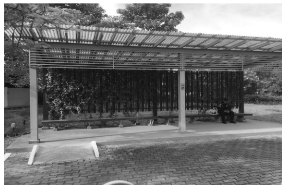
รูปที่ 2 จุดรอรถรางมีทางลาดสำหรับรถเข็น
